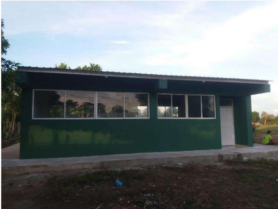
Construcción de Aula para la I.E Ciquí
