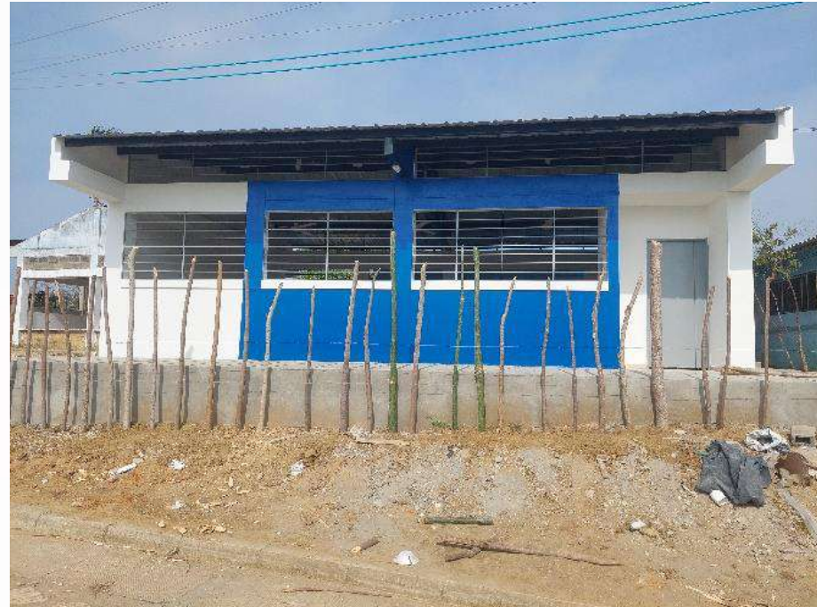
Construcción de aula en Nueva Estrella
