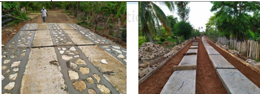
Ilustración 28. Construcción de placa huella sector El Salvador Fuente: Secretaría de Infraestructura
