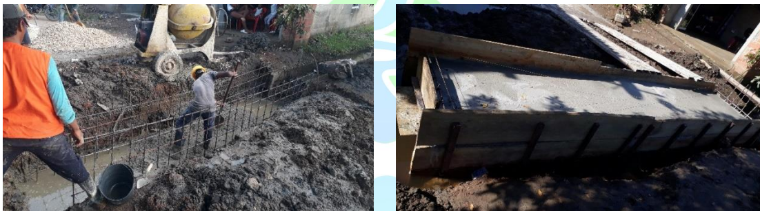
Ilustración 32. Construcción de Bouxculvert sector Los Bautistas Fuente: Secretaría de Infraestructura
