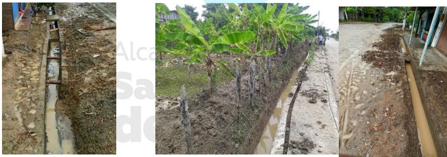
Ilustración 41. Mantenimiento de los Canales para aguas servidas en el corregimiento de José Manuel de Altamira
