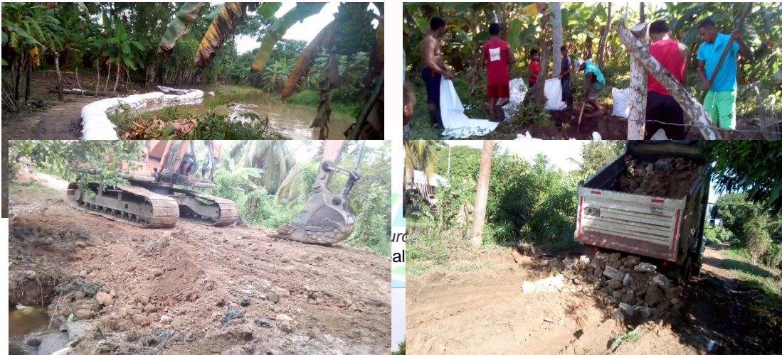
Ilustración 38. Construcción de taludes para el control de inundaciones Fuente: Oficina Municipal de Gestión del Riesgo
