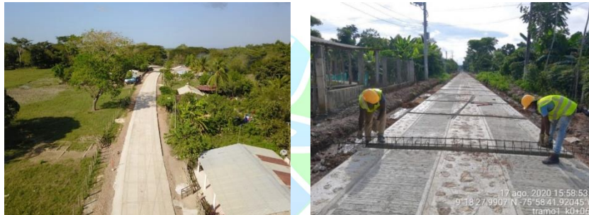
Ilustración 27. Construcción de placa huella corregimiento Pajonal y San José de las Cañas Fuente: Secretaria de Infraestructura
