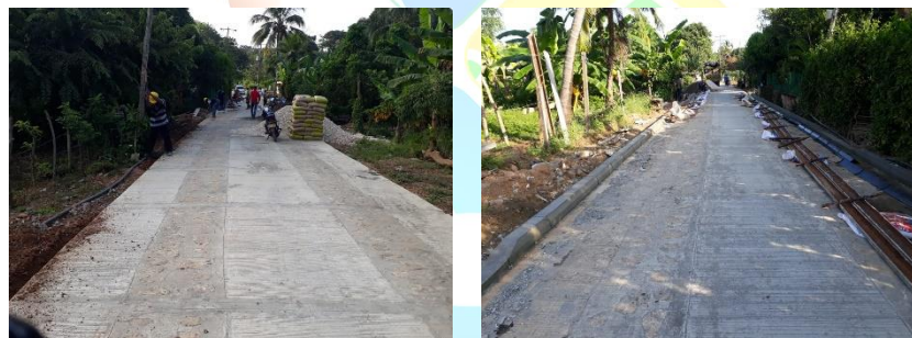
Ilustración 26. Construcción de placa huella sector Los Bautistas Fuente: Secretaria de Infraestructura
