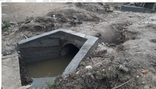
Ilustración 40. Mantenimiento de los Canales para aguas servidas en el corregimiento de Paso Nuevo, construcción e instalación de Husillos Fuente: Secretaria de Infraestructura
