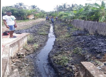
Ilustración 40. Mantenimiento de los Canales para aguas servidas en el corregimiento de Paso Nuevo, construcción e instalación de Husillos Fuente: Secretaria de Infraestructura
