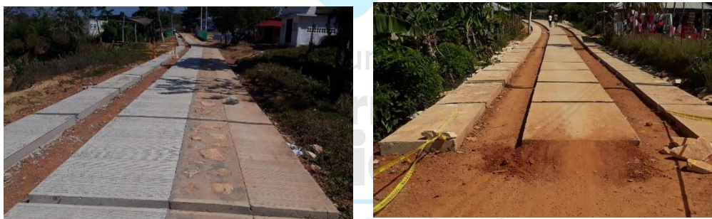
Ilustración 25. Construcción de Placa Huella en Nueva Estrella Fuente: Secretaria de Infraestructura
