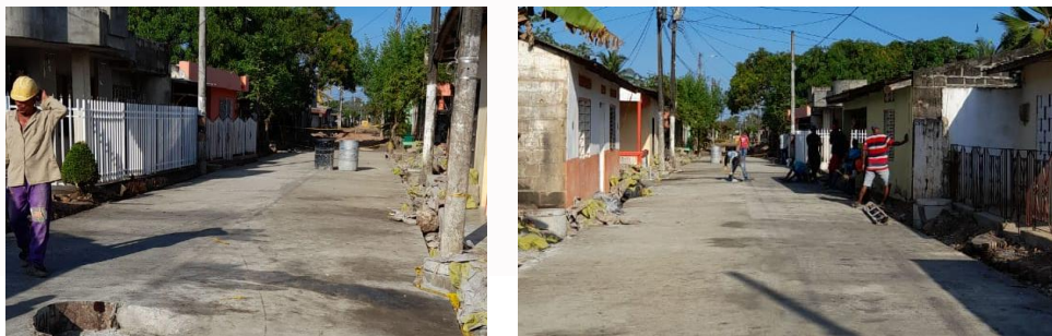
Ilustración 33. Construcción de Pavimento Hidráulico casco urbano Fuente: Secretaría de Infraestructura
