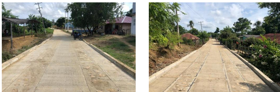
Ilustración 25. Placa Huella terminada en Nueva Estrella Fuente: Secretaria de Infraestructura
